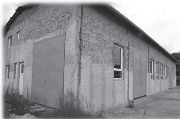
Vybudovaná hala Obecného podniku (OP)
