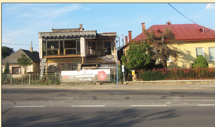
Prestavaný obchod na poschodový dom (foto z roku 2018)
