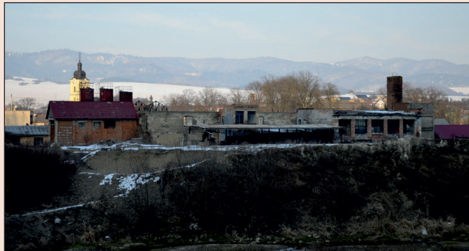
Hala novej garbiarne v roku 2018 a rekonštrukcia jej strechy. Počas prevádzky podniku Prefa sa k nej pozdĺžne pribudovali prístavby. Objekt garbiarne z kameňa v strede.
